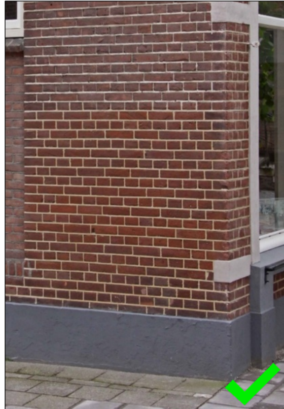
Eerst is de spatplint hersteld tot 40 cm onder maaiveld. Na voldoende droging is voegwerk hersteld. Inboeten baksteen bleek niet nodig.
