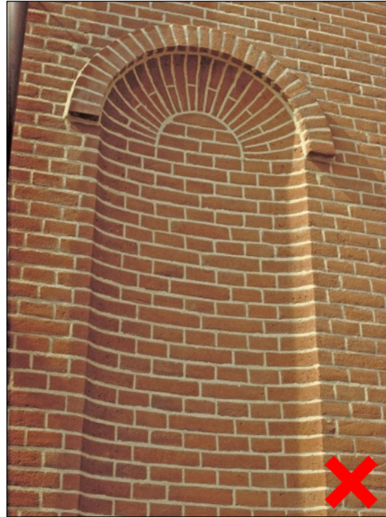
Enkele jaren later, exact dezelfde nis. Helaas, de voeger was op verzoek van de eigenaar (advocaat) langs geweest, die een fris ogende gevel wilde. U vraagt en wij draaien. Helaas, onherstelbaar vernield, dankzij te veel geld.
