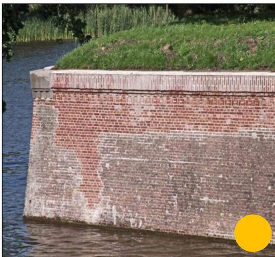
Herstel van grondkerend metselwerk van bastion in Naarden. Er is bewust door de opdrachtgever afgezien van ontstoren.
