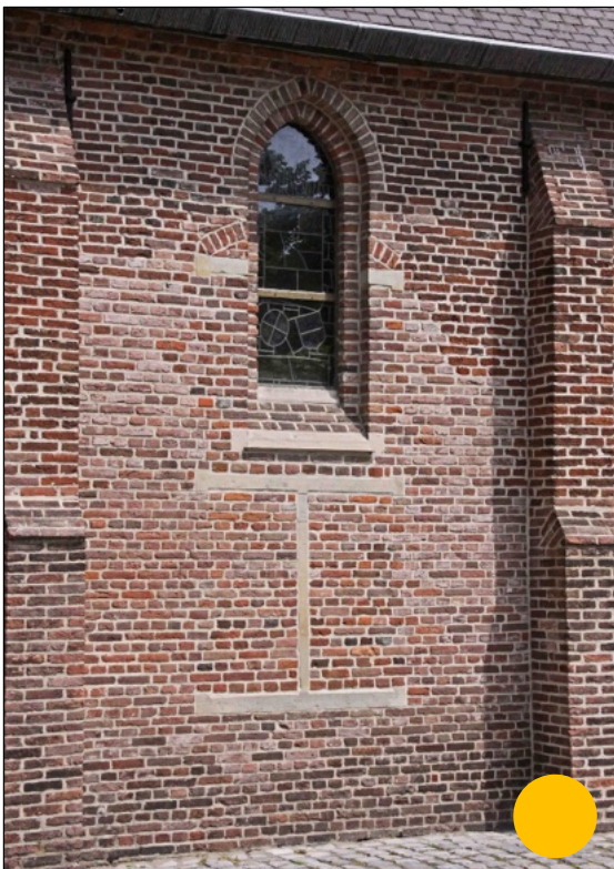
Herstel van metselwerk en voegwerk van een kerkje in Brabant. Er is niet gekozen voor bijkleuren.
