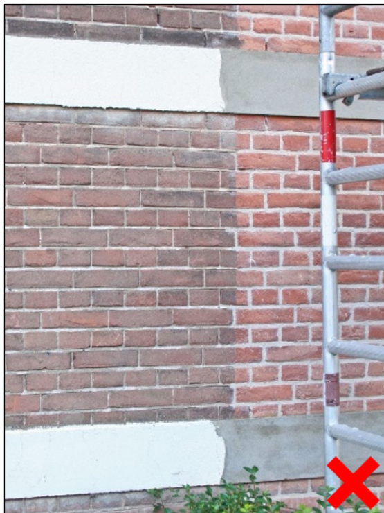
Dat krijg je bij twee-onder-een-kap. Links besneden voegwerk waar niets aan mankeert, hoogstens wat grau. Links gestraald en platvol gevoegd. Tja, het oog wil ook wat!
