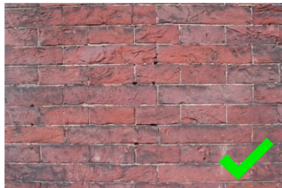
Zeer fijn besneden voegwerk uit de 18e eeuw. Niets aan doen, gaatjes dichtzetten met een beetje kalksmurrie in een bakkerspuit.
