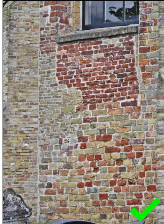
Dezelfde koorsluiting na het voorzichtig herstel van het voegwerk. Inboeten van baksteen bleek niet nodig. Voorbeeldig herstel.
