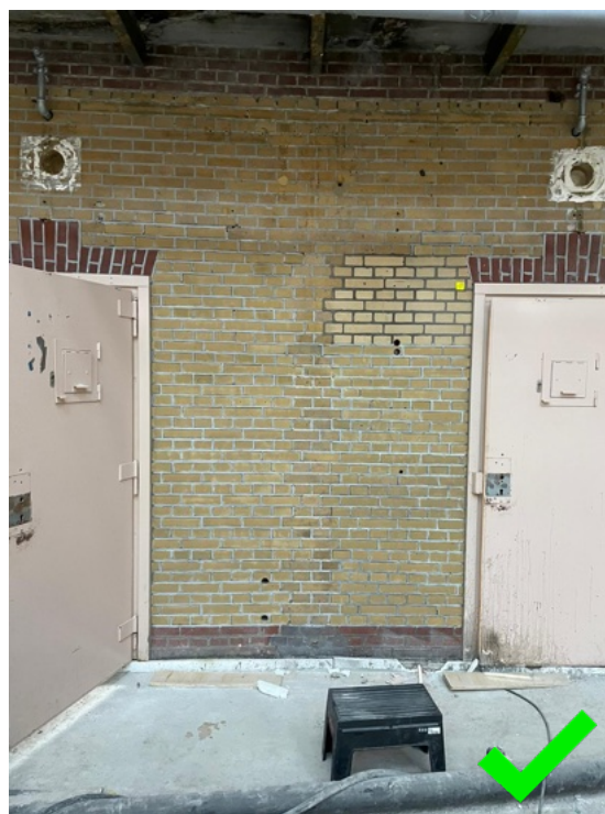
Begonnen met ontstoren van het nieuwe metselwerk. Een zeer acceptabel resultaat.
