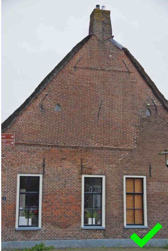
Topgevel van een Drentse boerderij waarbij over de gehele gevel het nodige voegwerk is hersteld. Ontstoren is niet nodig.
