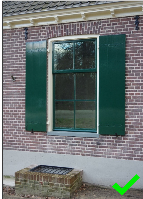
Bij de reconstructie van het venster is het metselwerk hersteld. De iets te lichte tweedehands baksteen is bijgekleurd voor een strak beeld.
