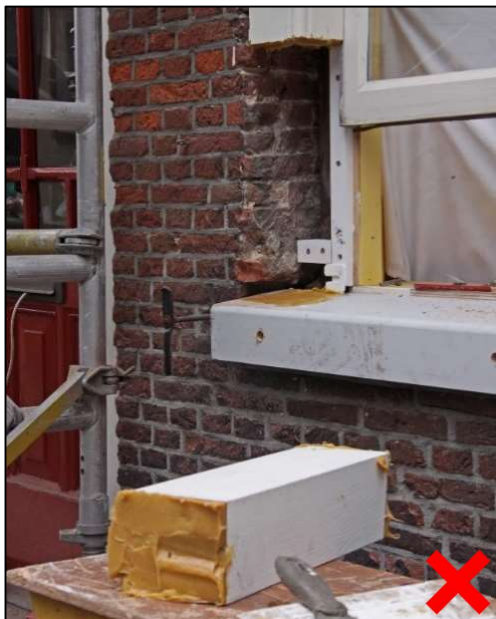
Het plakt en gaat enorm snel. Een reparatie van een leuk woonhuis uit de 19e eeuw in Delft. Heel informatief hoe een klussenier een kozijn onherstelbaar restaureert. De werkwijze voldoet op geen enkele manier aan de URL 4001 'Historisch timmerwerk'.
