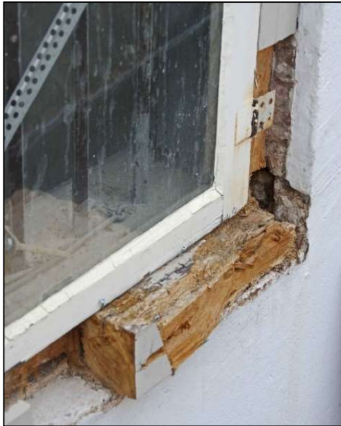
Hoe sneller hoe beter? Een zwaar aangetaste onderdorpel met kozijnstijl.
