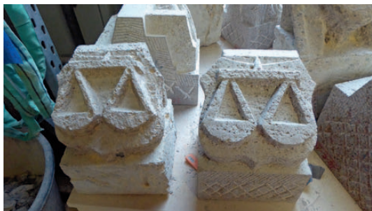
Verweerde delen worden vervangen.
