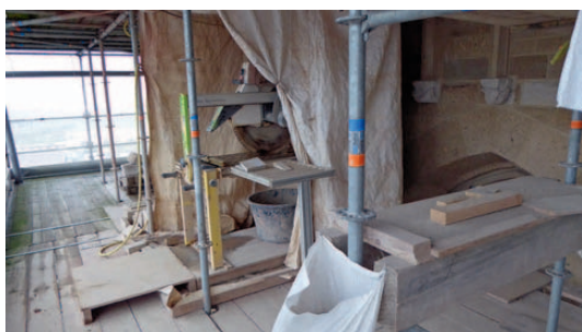
Kleine natuurstenen delen worden op de steiger op maat gemaakt op een zaag-machine die aan alle arbo-eisen voldoet. Een efficiënte aanpak.
