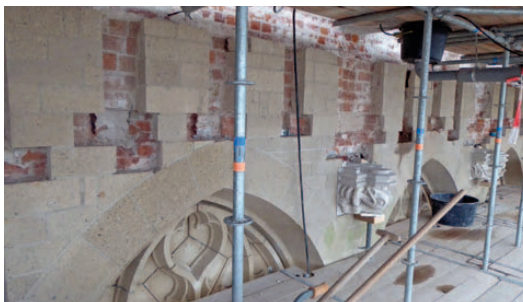
De gevel is gedeeltelijk ontdaan van zijn natuurstenen bekleding. Het onderliggende bakstenen metselwerk is zichtbaar.
