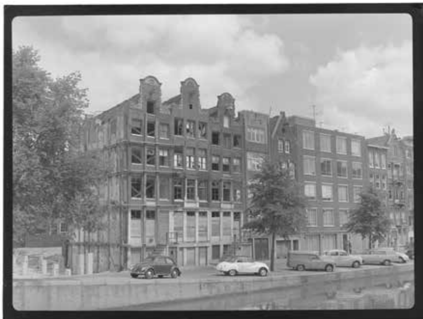
In 1962 stonden de panden er in deplorabele toestand bij. Op deze foto is te zien dat het middelste pand oorspronkelijk vanaf de tweede verdieping een andere opbouw had, met hogere ramen en dus verdiepingen op de derde en vierde woonlaag. Foto Stadsarchief Amsterdam.
