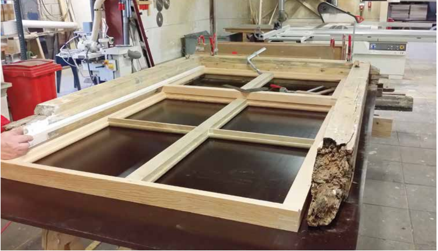
In de werkplaats van Cuppens +zn zijn de oude kozijnen zorgvuldig hersteld met behoud van zoveel mogelijk historisch materiaal. Een staaltje vakmanschap!
