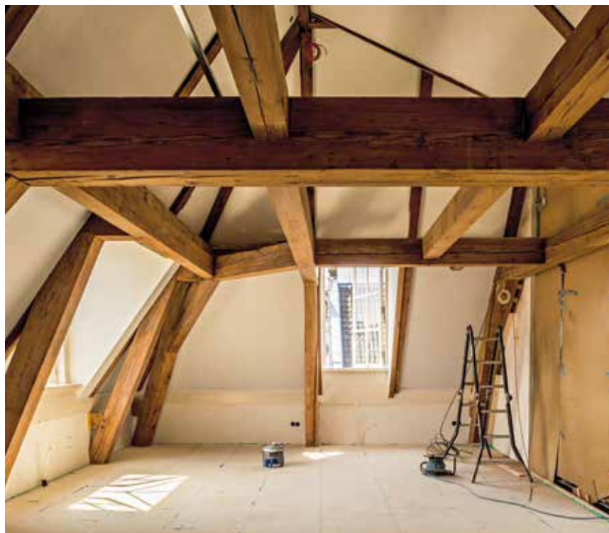
Martin: 'De kapconstructie is nog helemaal origineel en in uitzonderlijk goede staat.'
