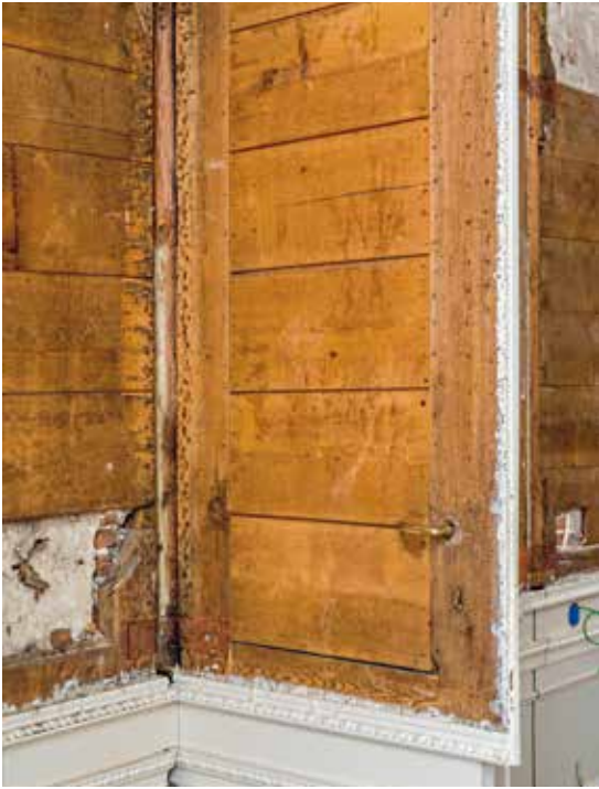
Vakmanschap van weleer: de deurconstructie die achter de linnen bespanning verborgen zit.
