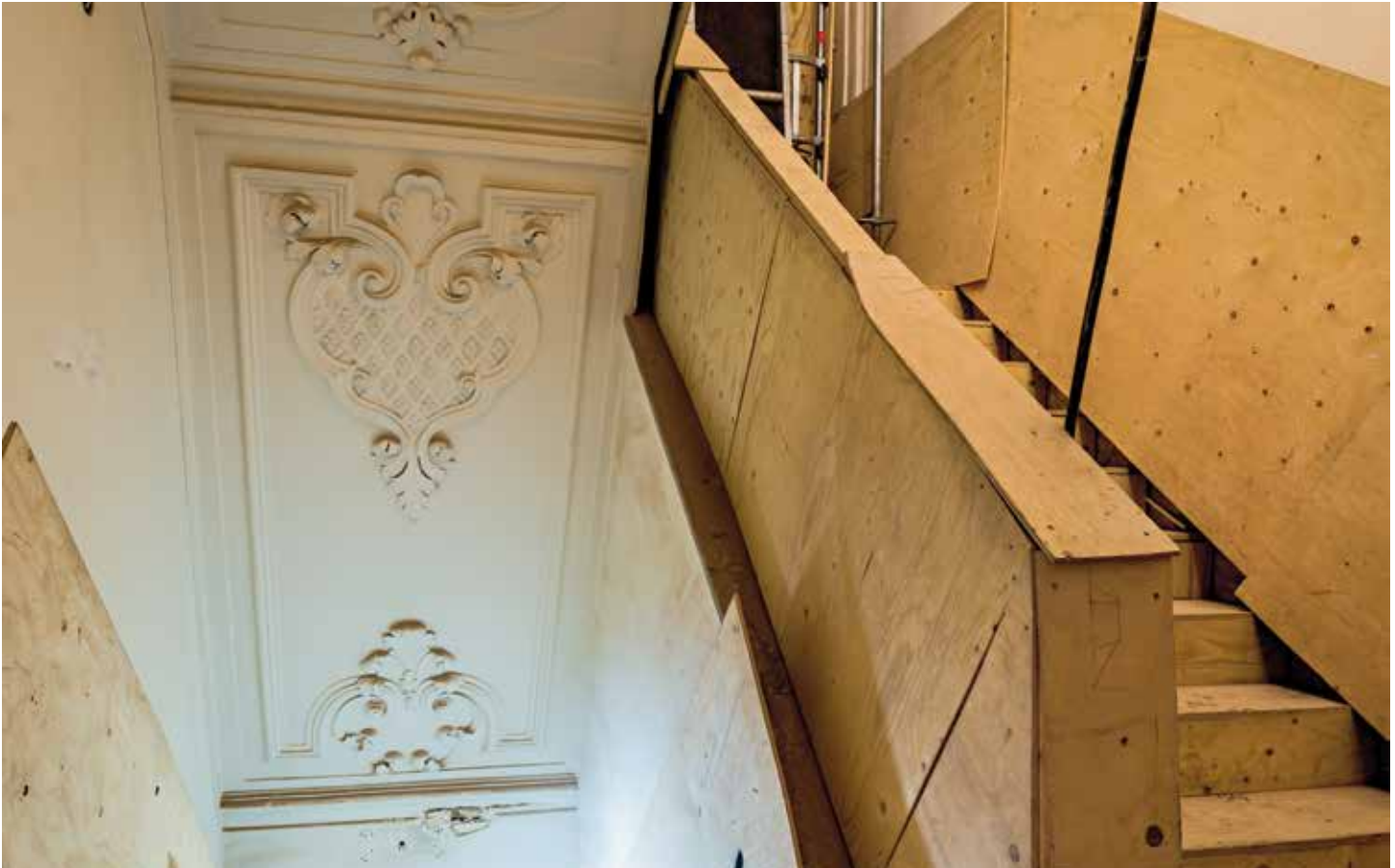
De monumentale delen van de trap zijn goed ingepakt tijdens de restauratie.
