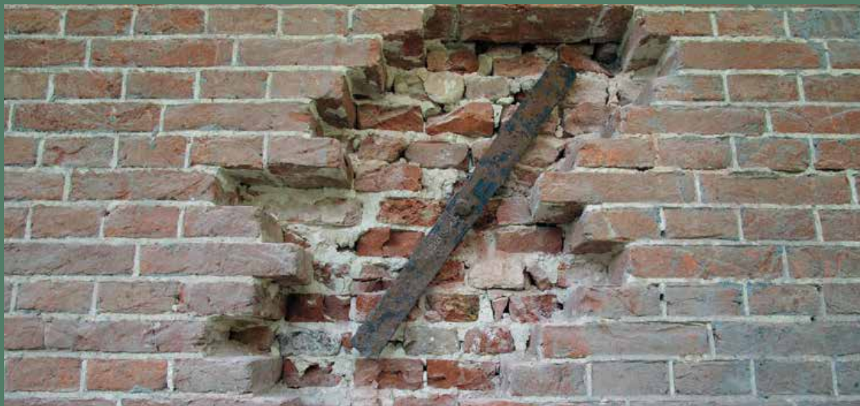
Een vrij gelegd muuranker (Foto Rijksdienst voor het Cultureel Erfgoed)
